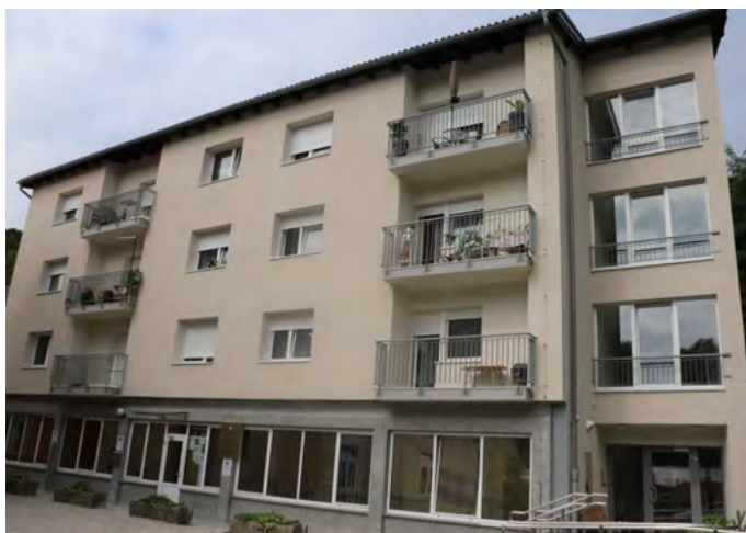
Pogled na prenovljeni objekt
