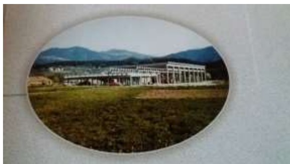
Gradnja hale v letu 1975
